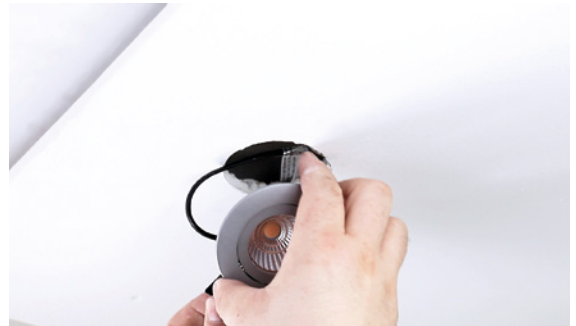
5 - Einsetzen des Spots in den Deckenausschnitt
