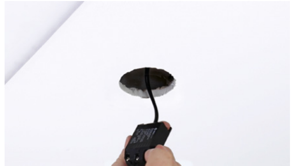
3 - Kompaktes Netzgerät wird in den Hohlraum eingeschoben
