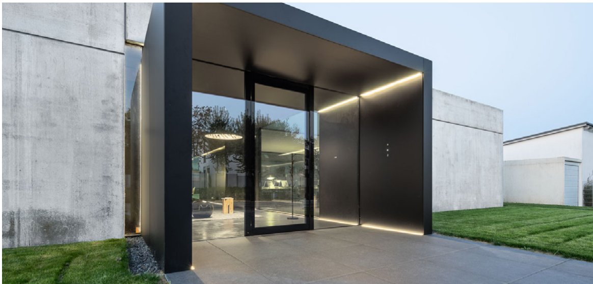
Foto: Daniel Vieser . Architekturfotografie, Karlsruhe
